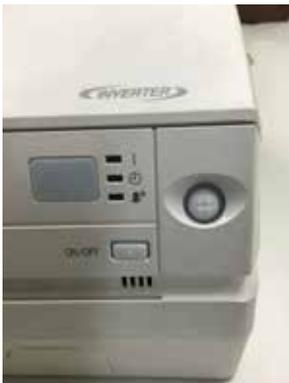
O SENSOR DE RAIOS INFRAVERMELHOS CONTROLA AUTOMATICAMENTE A OPERAÇÃO DO AR CONDICIONADO DE ACORDO COM O MOVIMENTO NO AMBIENTE. QUANDO NÃO HÁ NENHUM MOVIMENTO, A TEMPERATURA É AJUSTADA +/- 2°C PARA ECONOMIZAR ENERGIA.
