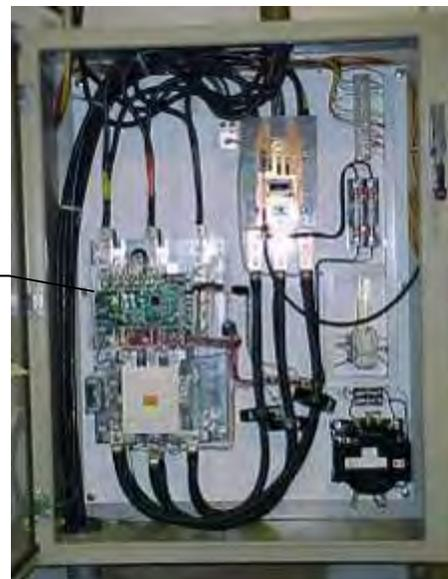
Conexão da fiação no starter para exibição
